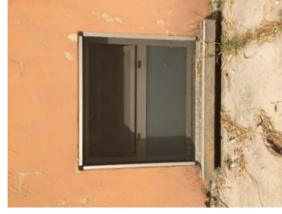
1 FINESTRA IN ALLUMINIO LATO CORTILE (INTERNO) (anno '90)
