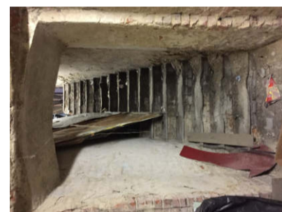
4 RAMPA DI SCALA 4 (ANNO 1881)
