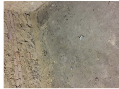
1 PAVIMENTI IN TERRA BATTUTA DA SOSTITUIRE CON NUOVO PAVIMENTO (ANNO 1985)
