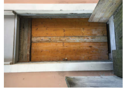
7 CHIUSURA CON PANNELLATURE IN LEGNO (serramento fissato nel 2010)
