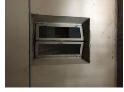
5 FINESTRA IN LEGNO IN AFFACCIO ALLA SCALA (anno 1881)
