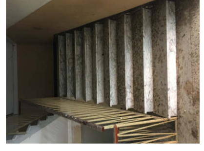
3 RAMPA DI SCALA 3 (anno 1958)
