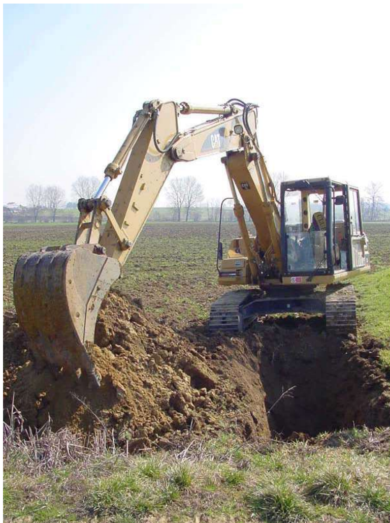
Foto n°18: Particolare delle fasi di scavo delle trincee geognostiche
