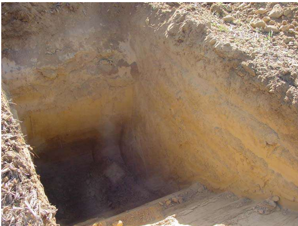
Foto n°33: Particolare dei limi argillosi chiari oggetto di escavazione
