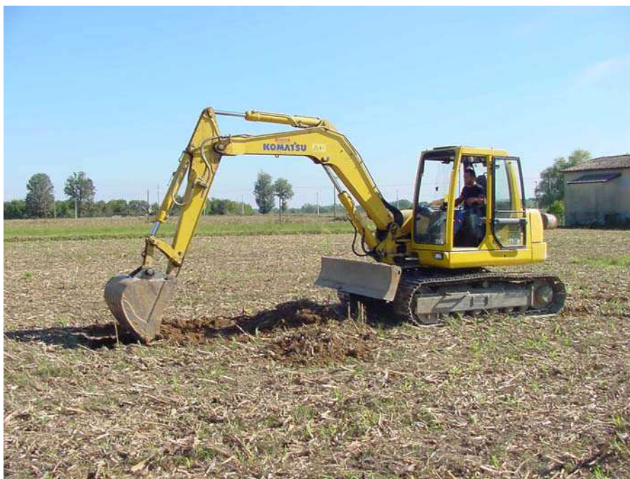
Foto n°32: Fasi della campagna di trincee geognostiche
