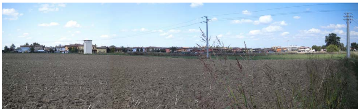
Figura 19 - Vista da sud del settore ovest dell'ANIR2. Si nota la linea elettrica MT e la cabina elettrica che insistono nell'ambito.
