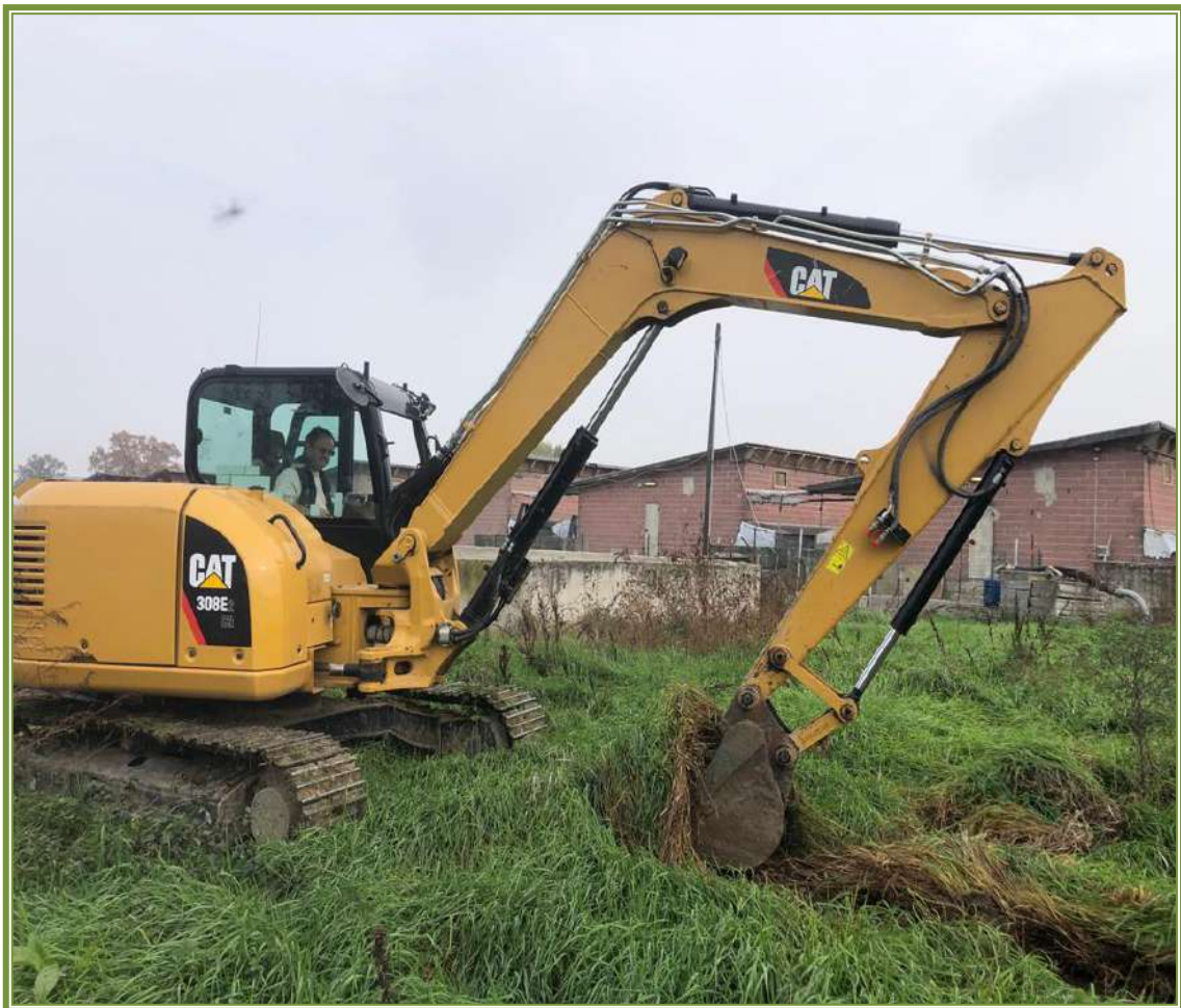
Fig. 18: Realizzazione di trincea mediante escavatore.
