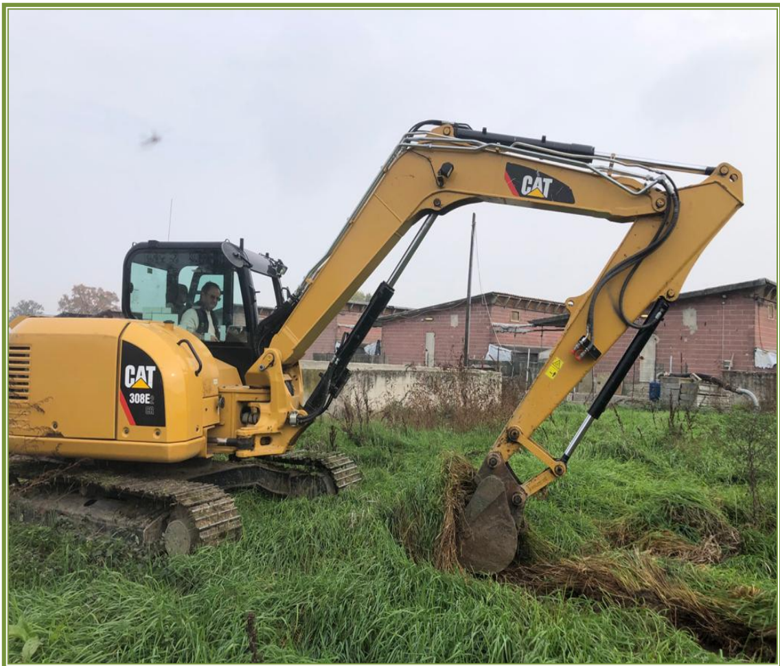
Fig. 18: Realizzazione di trincea mediante escavatore.
